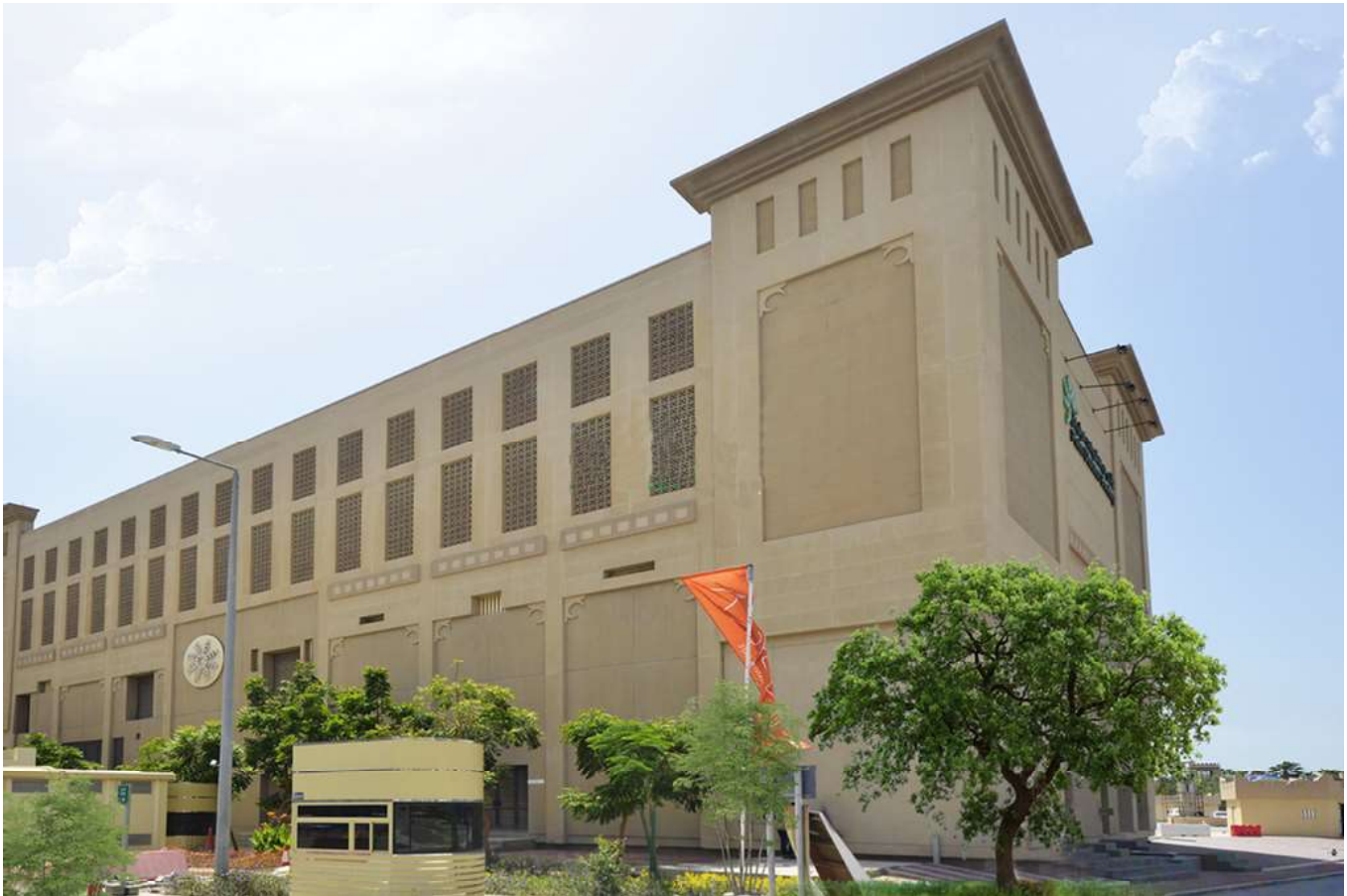
מתקני הקירור של דובאי: חזית קלאסית שמסתירה מנועי מזגנים (צילום מתוך האתר: adcenergysystems.com )
