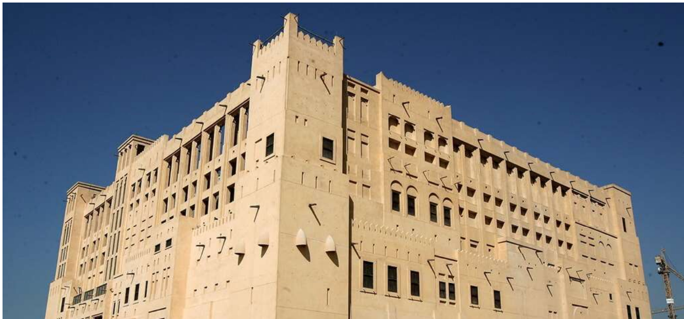
האדריכלות של מתקני הקירור: להזכיר טכניקות קירור מסורתיות (צילום מתוך האתר: transgulfem.com)
